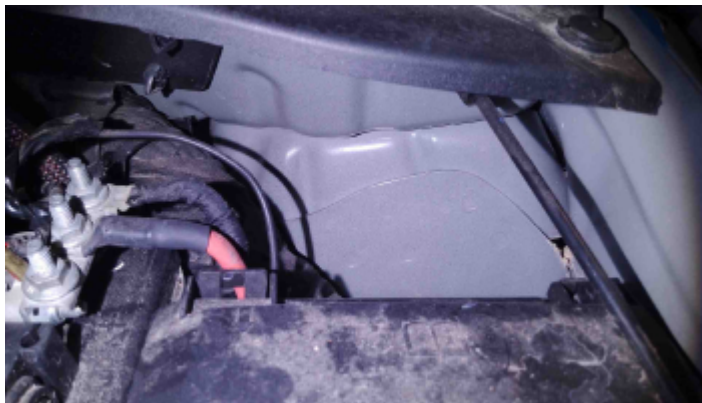
Foto Estrutura Torre do Amortecedor Esquerdo
