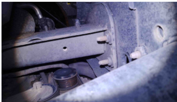
Foto Estrutura Longarina Direita
