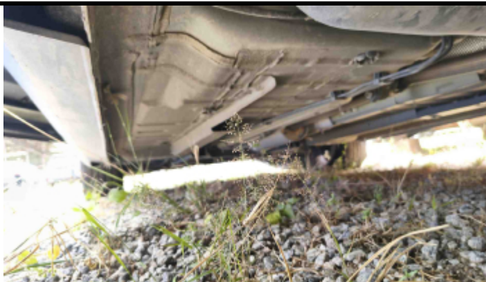
Foto Estrutura Assoalho
