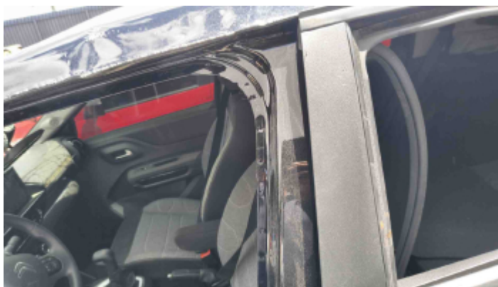
Foto Estrutura Coluna Central Esquerda
