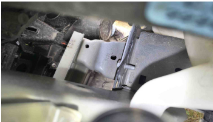
Foto Estrutura Longarina Direita
