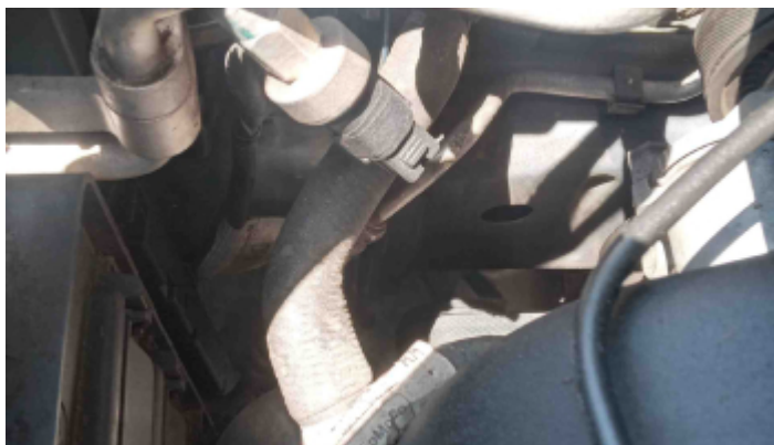
Foto Estrutura Longarina Direita
