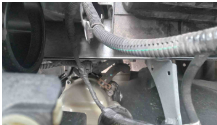
Foto Estrutura Longarina Esquerda
