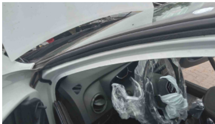
Foto Estrutura Coluna Dianteira Esquerda
