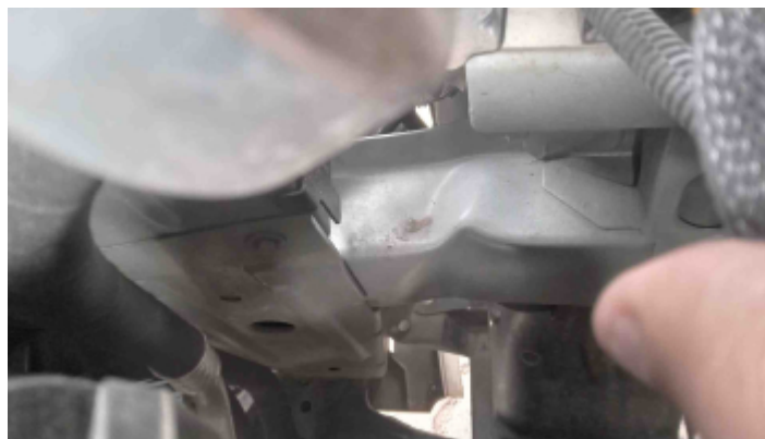
Foto Estrutura Longarina Direita
