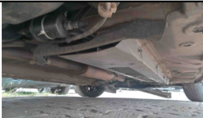
Foto Estrutura Assoalho
