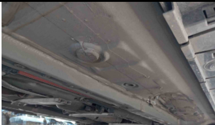
Foto Estrutura Assoalho
