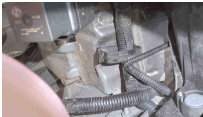
Foto Estrutura Longarina Esquerda
