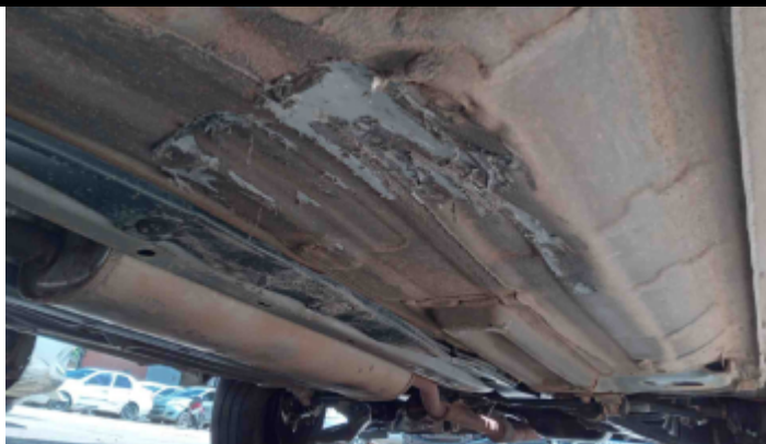
Foto Estrutura Assoalho
