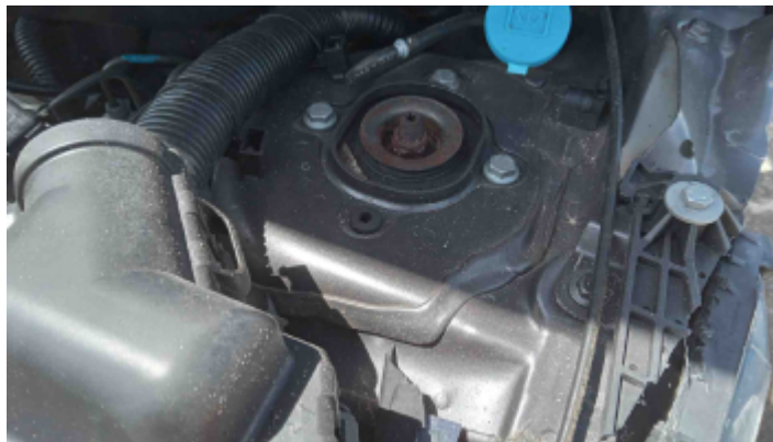
Foto Estrutura Torre do Amortecedor Esquerdo
