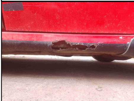
CAIXAS DE AR - SOLEIRA ESQUERDA
