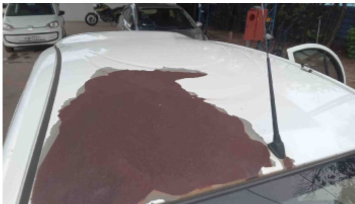
Foto Estrutura Teto
