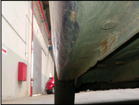
CAIXA DE AR/ SOLEIRA ESQUERDA
