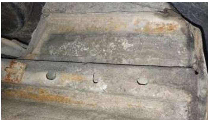
Estrutura Longarina Traseira Esquerda
