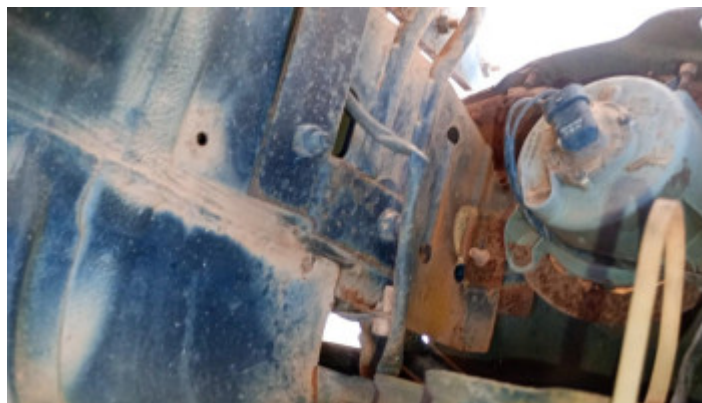
Estrutura Longarina Esquerda
