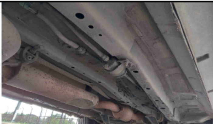
Foto Estrutura Assoalho
