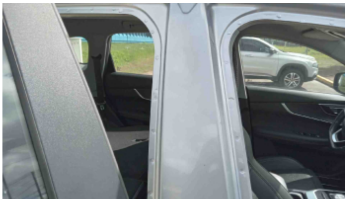
Foto Estrutura Coluna Central Direita
