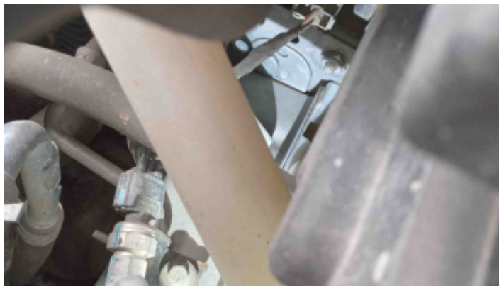
Foto Estrutura Longarina Direita
