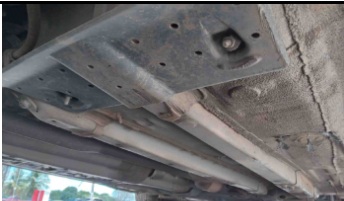
Foto Estrutura Assoalho
