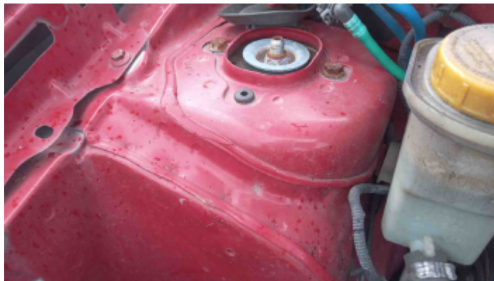
Foto Estrutura Torre do Amortecedor Direito
