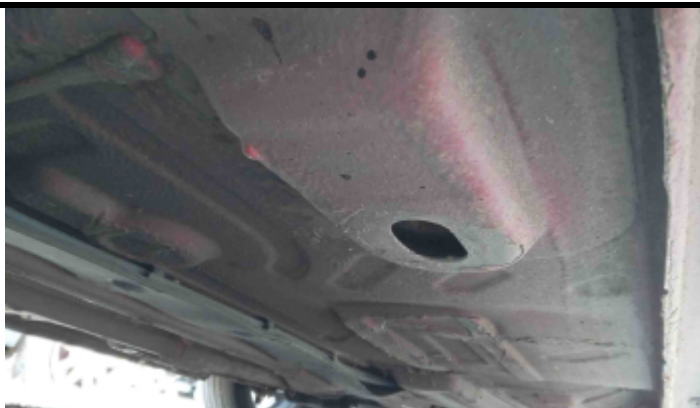
Foto Estrutura Assoalho
