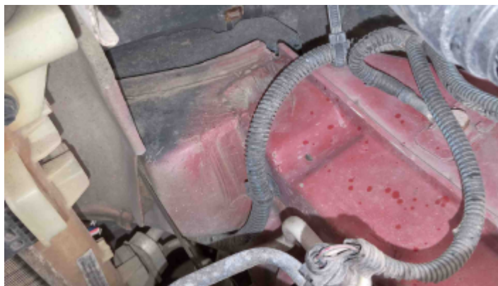
Foto Estrutura Longarina Direita
