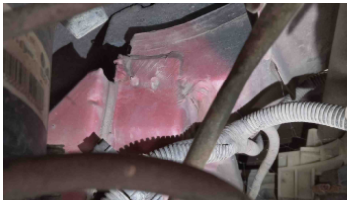
Foto Estrutura Longarina Esquerda
