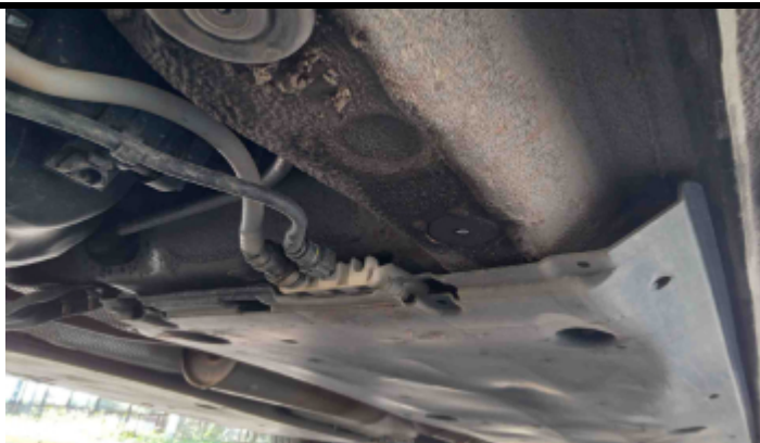
Foto Estrutura Assoalho
