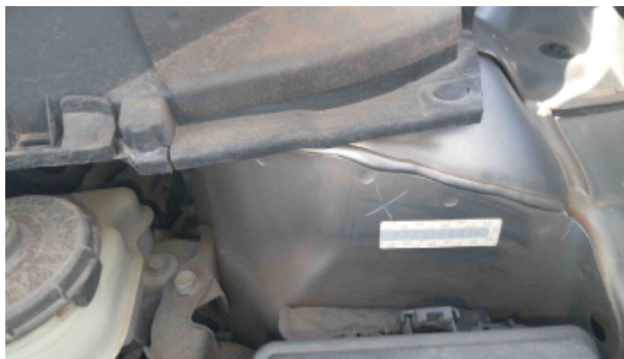
Foto Estrutura Torre do Amortecedor Esquerdo
