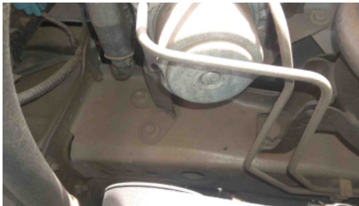
Foto Estrutura Longarina Direita
