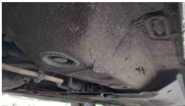
Foto Estrutura Assoalho
