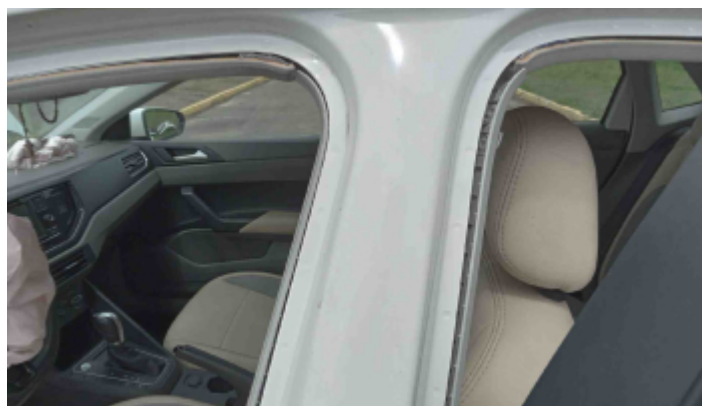
Foto Estrutura Coluna Central Esquerda
