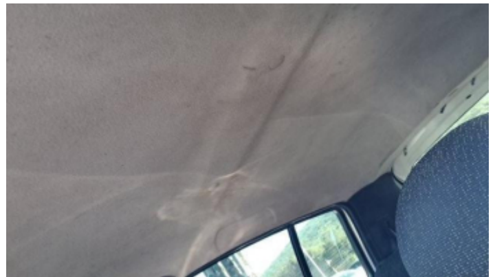
REVESTIMENTO DO TETO
