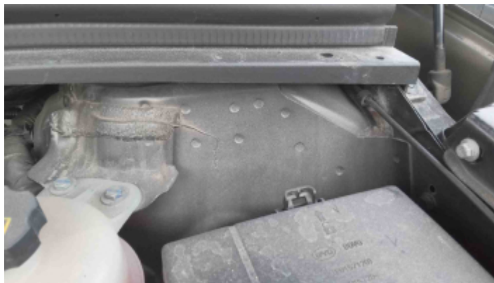
Foto Estrutura Torre do Amortecedor Esquerdo
