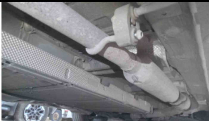
Foto Estrutura Assoalho
