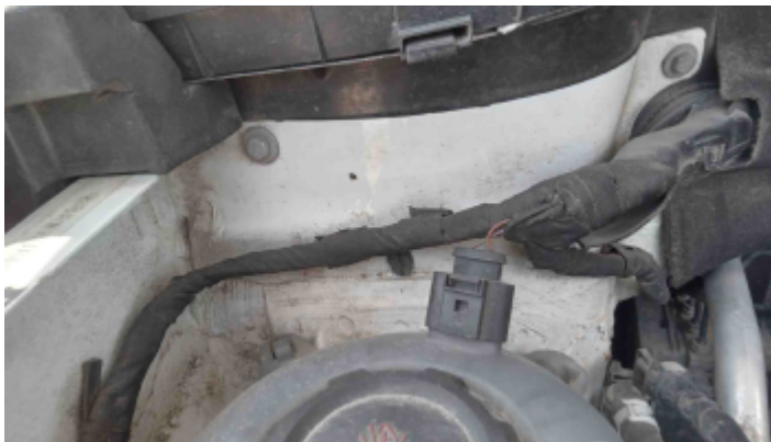
Foto Estrutura Torre do Amortecedor Direito
