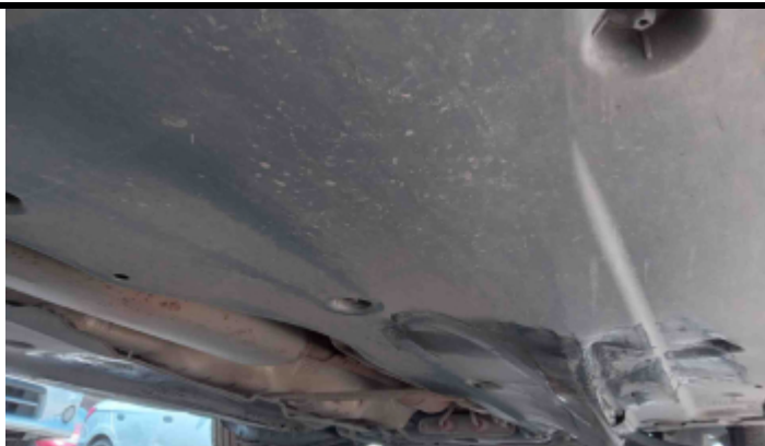
Foto Estrutura Assoalho
