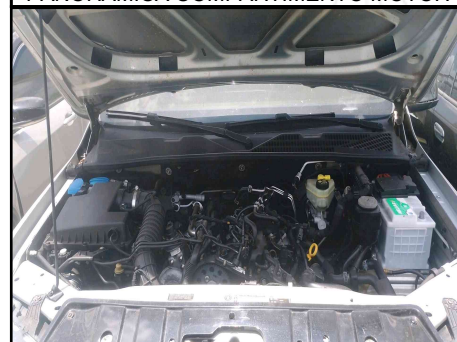
PANORAMICA COMPARTIMENTO MOTOR
