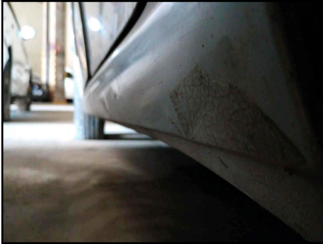
CAIXA DE AR/ SOLEIRA ESQUERDA
