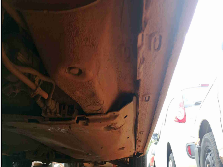
CAIXAS DE AR - SOLEIRA DIREITA
