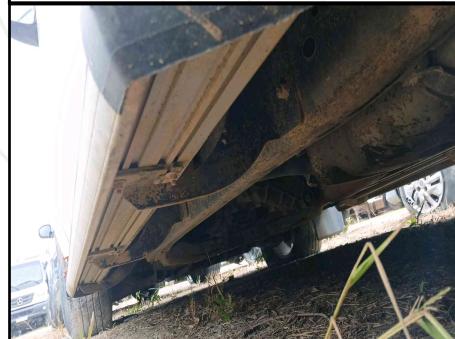
CAIXA DE AR/ SOLEIRA ESQUERDA
