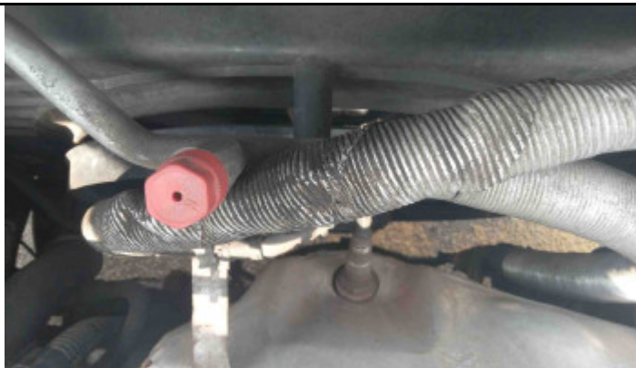
Foto Ar Condicionado
