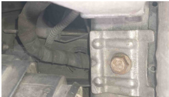
Foto Estrutura Longarina Esquerda
