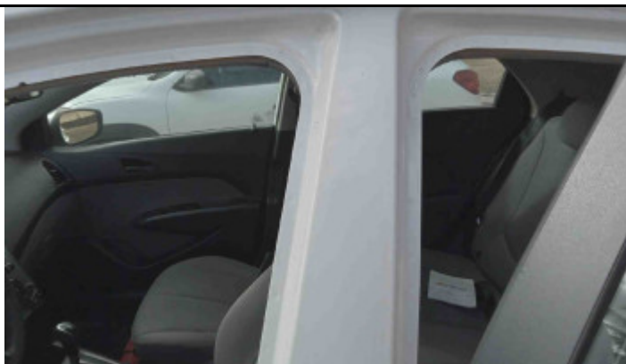
Foto Estrutura Coluna Central Esquerda
