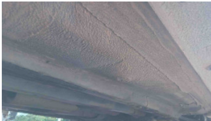
Foto Estrutura Assoalho
