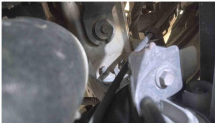
Foto Estrutura Longarina Esquerda
