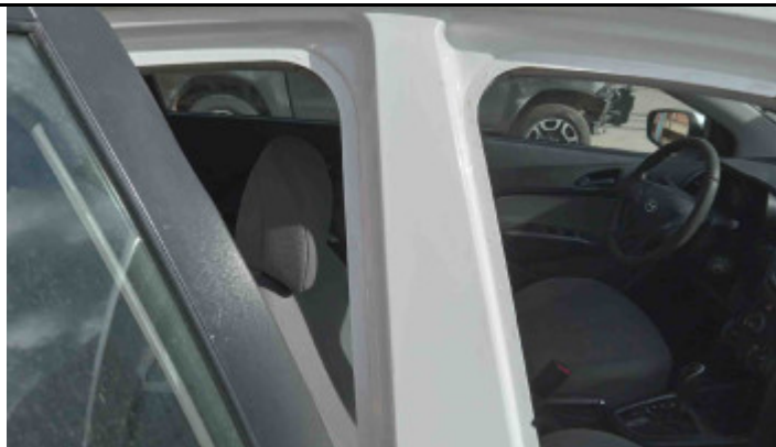
Foto Estrutura Coluna Central Direita
