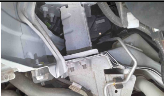
Foto Estrutura Longarina Direita
