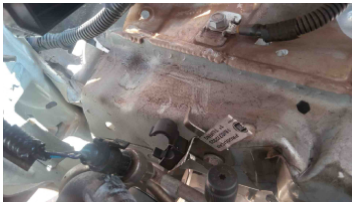
Foto Estrutura Longarina Direita
