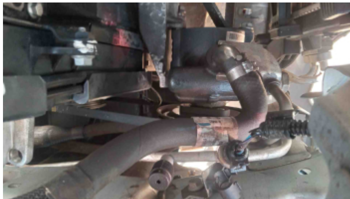
Foto Ar Condicionado
