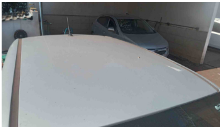
Foto Estrutura Teto
