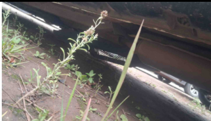
Foto Estrutura Assoalho
