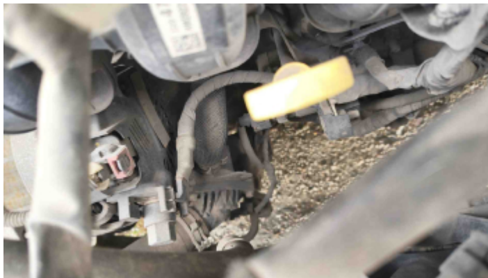
Foto Ar Condicionado
