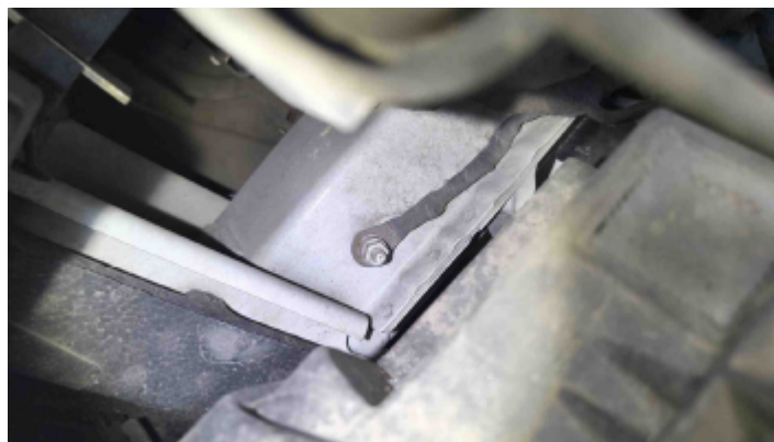
Foto Estrutura Longarina Esquerda
