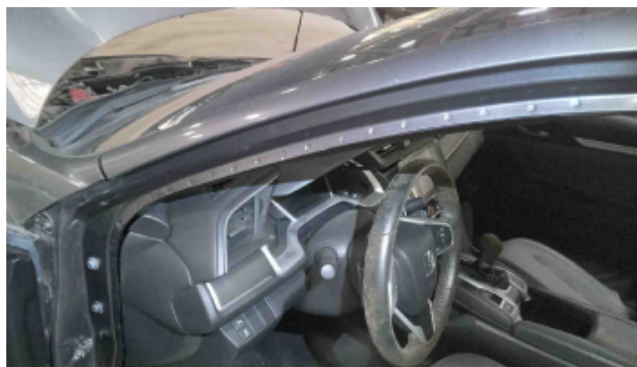
Foto Estrutura Coluna Dianteira Esquerda
