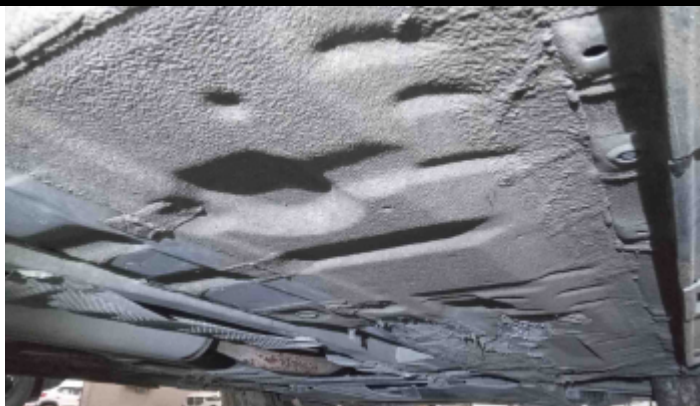
Foto Estrutura Assoalho
