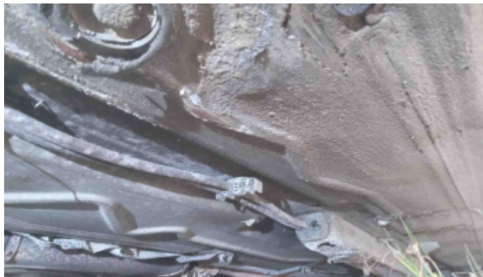
Foto Estrutura Assoalho
