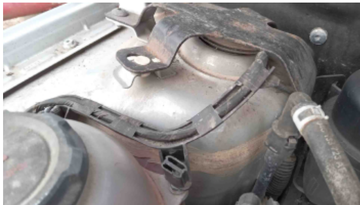
Foto Estrutura Torre do Amortecedor Direito
