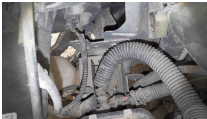
Foto Estrutura Longarina Esquerda
