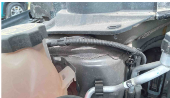
Foto Estrutura Torre do Amortecedor Direito
