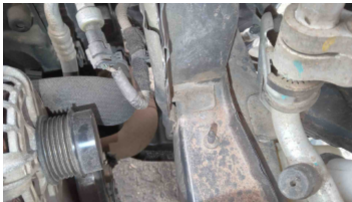
Foto Estrutura Longarina Direita
