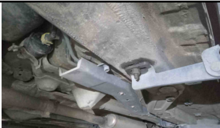
Foto Estrutura Assoalho
