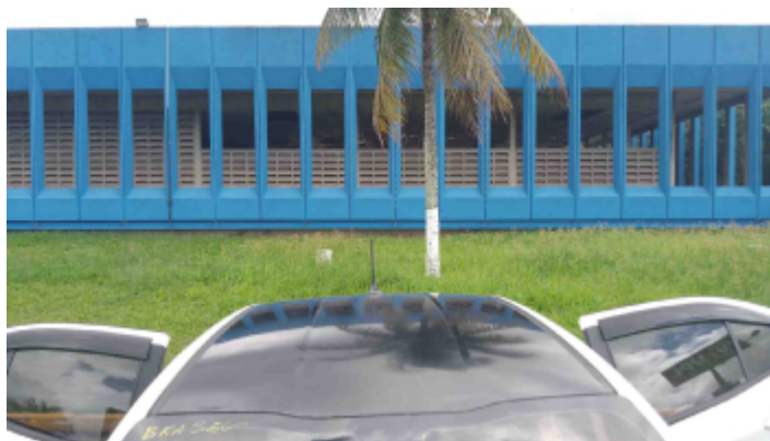
Foto Estrutura Teto
