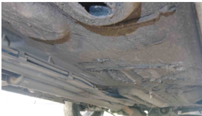
Foto Estrutura Assoalho
