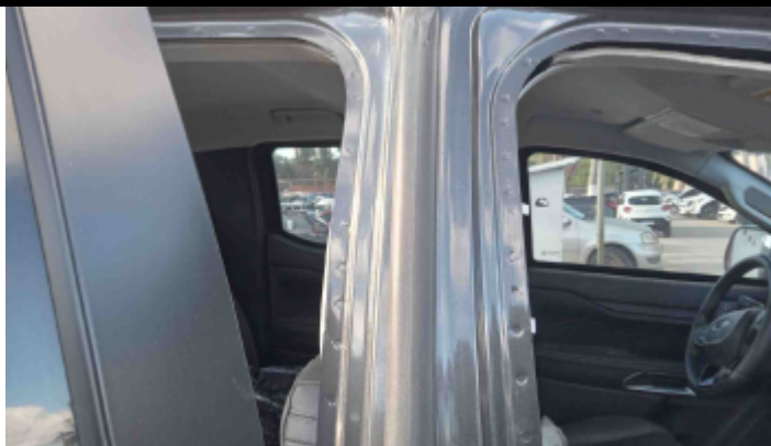
Foto Estrutura Coluna Central Direita
