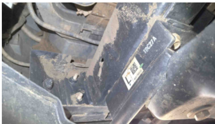
Foto Estrutura Longarina Esquerda
