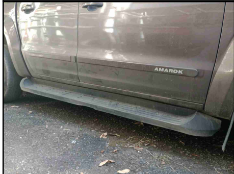
CAIXAS DE AR - SOLEIRA DIREITA
