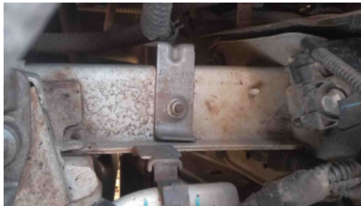
Foto Estrutura Longarina Direita
