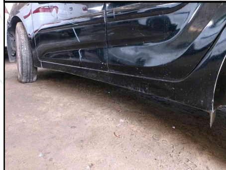
CAIXA DE AR/ SOLEIRA ESQUERDA
