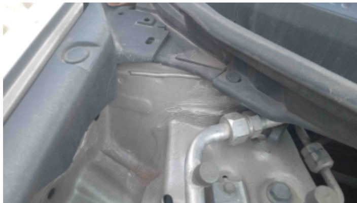
Foto Estrutura Torre do Amortecedor Direito
