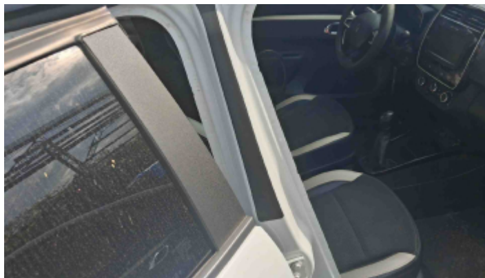
Foto Estrutura Coluna Central Direita
