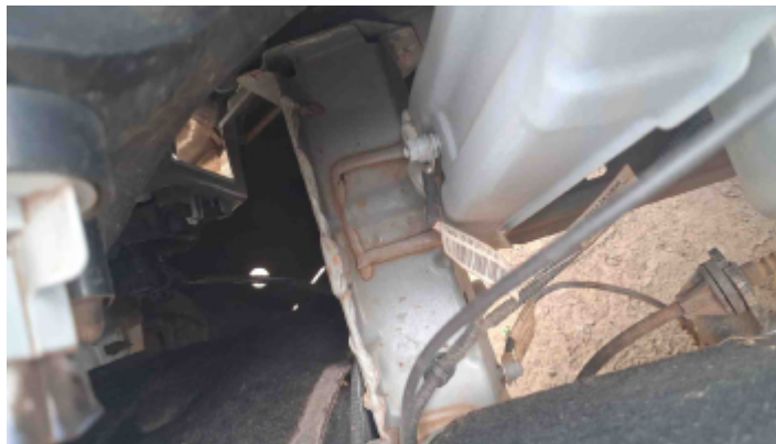
Foto Estrutura Longarina Esquerda
