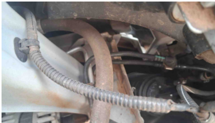
Foto Estrutura Longarina Direita
