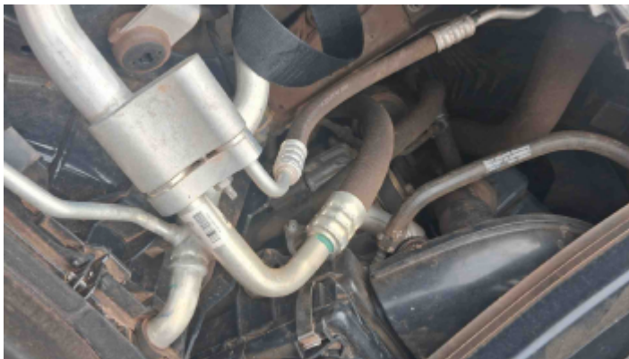
Foto Ar Condicionado
