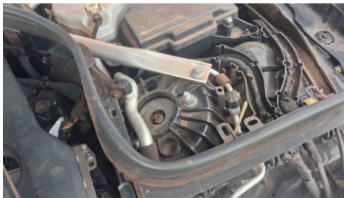
Foto Estrutura Torre do Amortecedor Esquerdo
