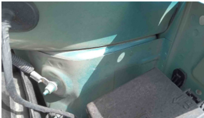
Foto Estrutura Torre do Amortecedor Esquerdo
