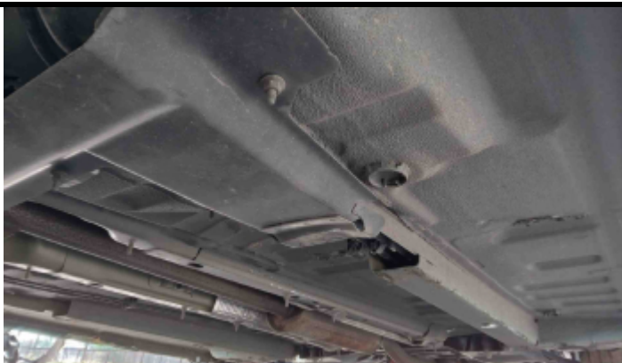
Foto Estrutura Assoalho
