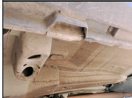
CAIXA DE AR/ SOLEIRA ESQUERDA
