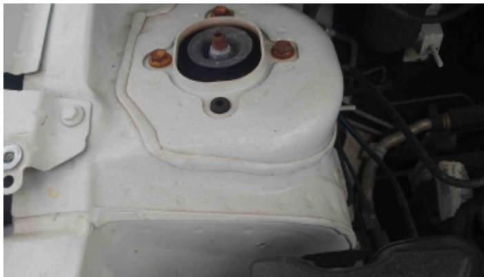
Foto Estrutura Torre do Amortecedor Direito
