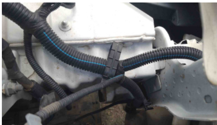
Foto Estrutura Longarina Esquerda
