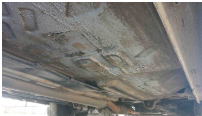
Foto Estrutura Assoalho
