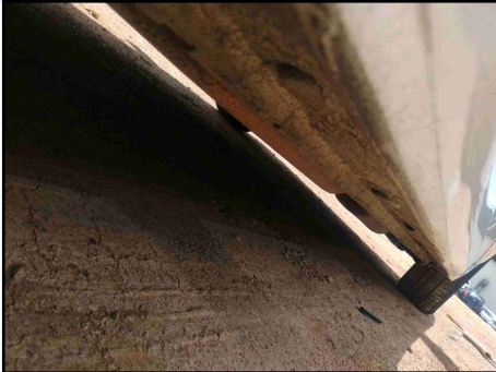
CAIXAS DE AR - SOLEIRA DIREITA
