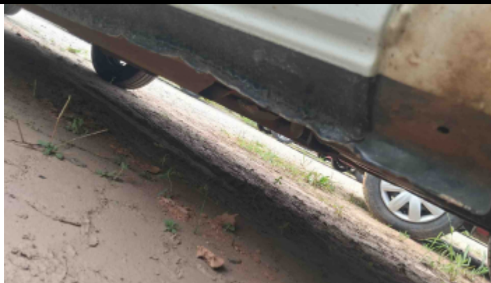
Foto Estrutura Assoalho
