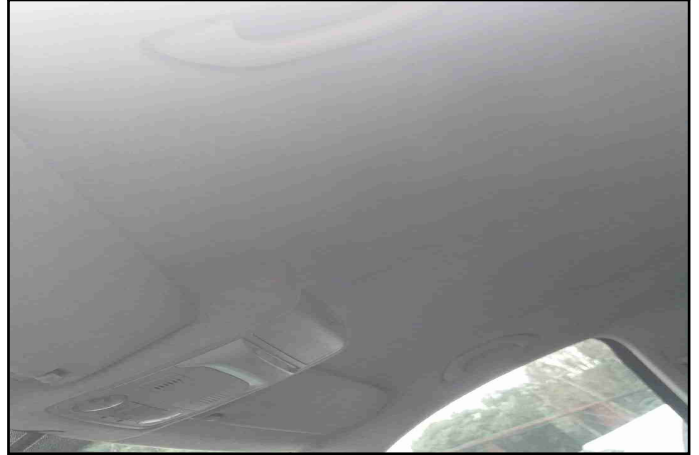
REVESTIMENTO DO TETO
